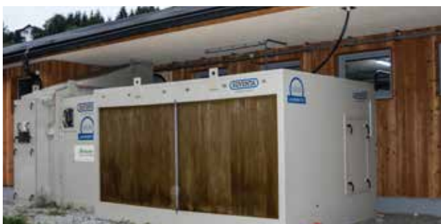
Kombinierte Abluftreinigungsanlage (Chemowäscher plus Biofilter)
