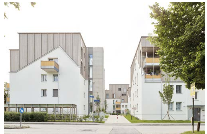
Abbildung 13: Wohnanlage Friedrich-Inhauer-Straße in Salzburg, Außenansicht seitlich; Bild: Atelier Wortmeyer
